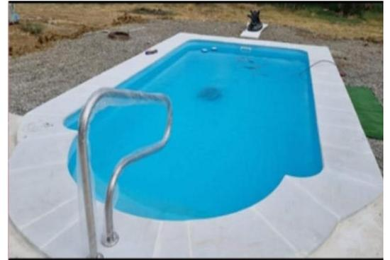
**PASAMANOS:** De acero inoxidable, con fijación de tornillos en la piedra de coronación, incluyen tapa embellecedora, tornillos, tacos de anclaje y junta
